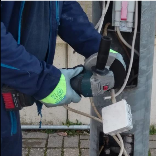
Austausch der alten Stromleitungen
