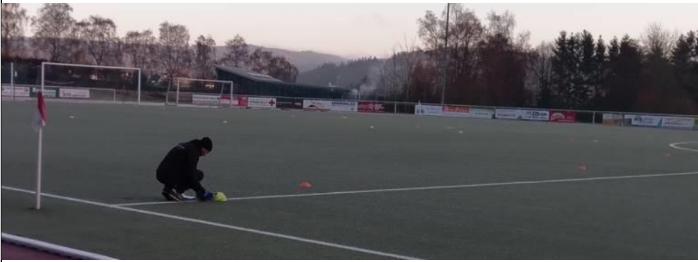
Aufstellen von Pylonen für die Ausrichtung der einzelnen LED-Sportplatzfluter
